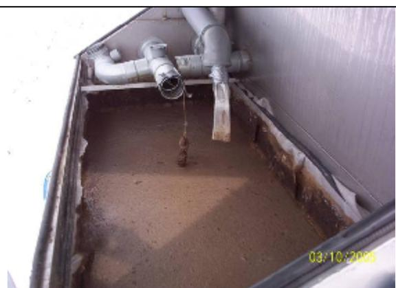
**Abbildung 9: Innenraum des Kompaktrockners mit Frisch- und Umlufteinrichtung nach der 1. Befüllung (M. Vallazza, 2005)**
