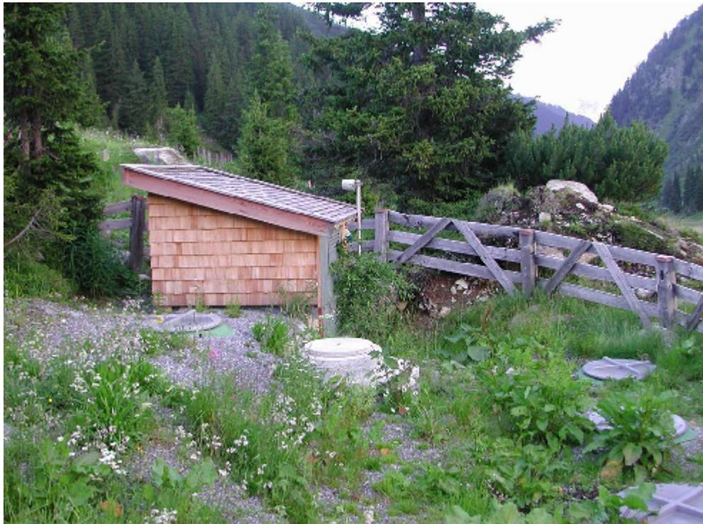
**Bild 6:** Ansicht der Kläranlage Konstanzer Hütte mit den Vorklärbehältern links und den Behältern der biologischen Stufe rechts im Bild
