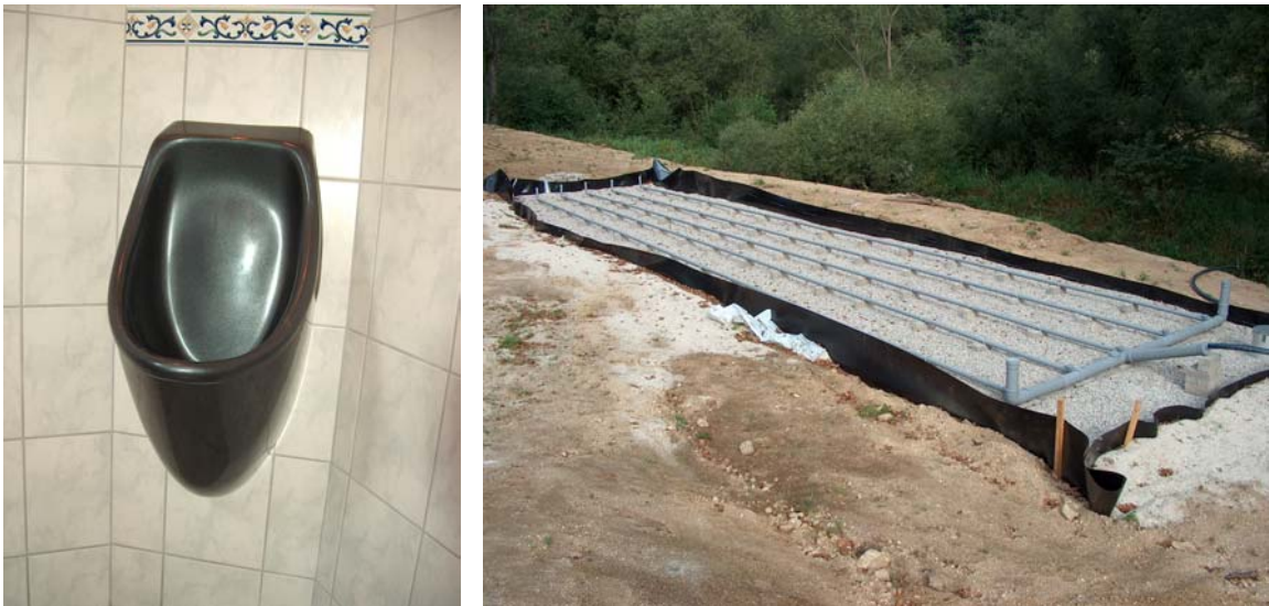
Abbildung 5: wasserlose Urinal & bepfanter Bodenfilter (in Bau)
