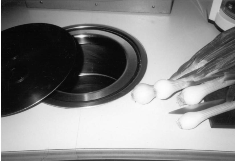
Abbildung 5: Küchenabwurf in Edelstahl in die Arbeitsplatte integriert
